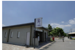
京都市営地下鉄烏丸線「国際会館」駅 徒歩 17 ～ 19 分
